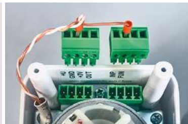
Фото 23. Подключение проводного выключателя
