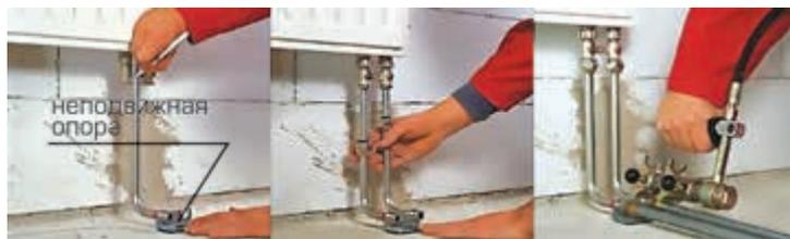
изменения длины подводок, вызванных перепадами температуры, при монтаже, трубки необходимо зафиксировать к полу точками неподвижной опоры (как показано на рисунке), с их последующей заливкой в бетонную стяжку.
