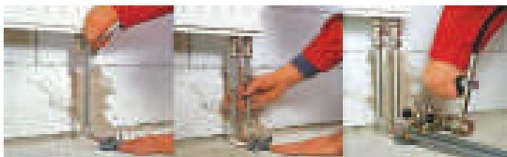
**Внимание!** Перед началом отопительного сезона следует производить осмотр компрессионных фитингов, в случае ослабления резьбового соединения, необходимо подтянуть накидную гайку.
