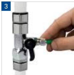
1. Установите тройник-адаптер (А) на магистраль холодной воды, уплотнив соединения (рис. 1).
