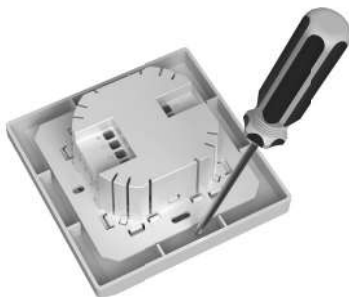
Рис. 5. Демонтаж лицевой панели
